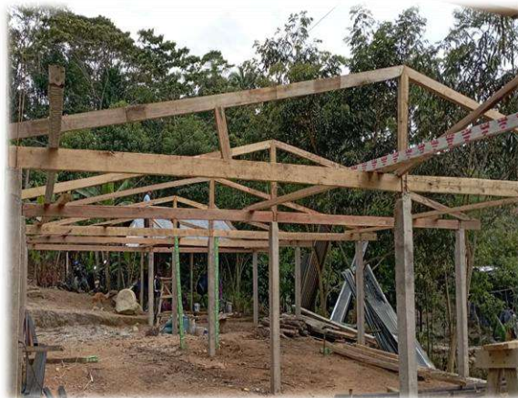
Infraestructura de la cubierta para el techo de la casa de remedio
