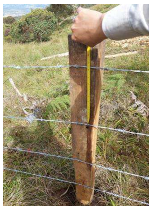
Verificación posteadura y aislamiento con alambre de Púas.
